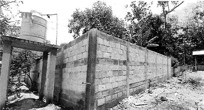
CONSTRUCCIÓN DE MURO PERIMETRAL, EN EL INGRESO AL ESTABLECIMIENTO..
