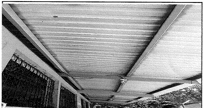
TRABAJO TERMINADO DE MANTENIMIENTO A LA ESTRUCTURA METÁLICA, EN LOS CORREDORES DE NUESTRA ESCUELA.
