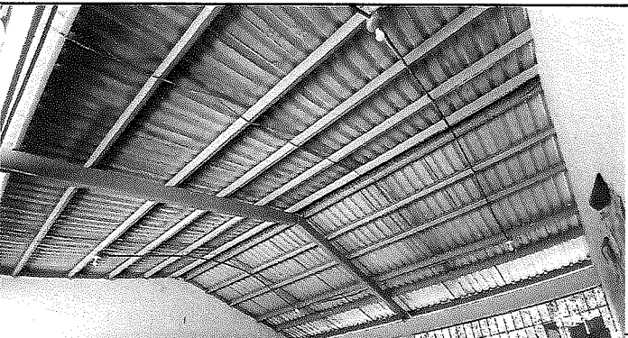
PINTADO DE LA ESTRUCTURA METÁLICA DEL TECHO DE NUESTRO ESTABLECIMIENTO.
